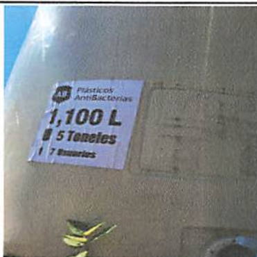
Foto 11: Sustitución de depósito de agua 1100 litros.
