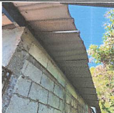
Foto 9: Sustitución de techo por lámina troquelada calibre 26.
