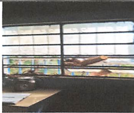
Foto 2: Sustitución de estructura de metal de ventana por aluminio.
