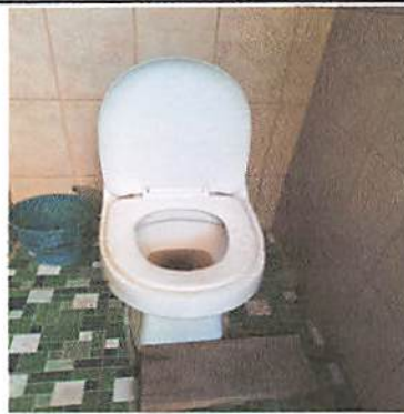
Foto 8: Sustitución e instalación de inodoro.
