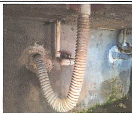
Foto 12: Reparación de lavamanos.
