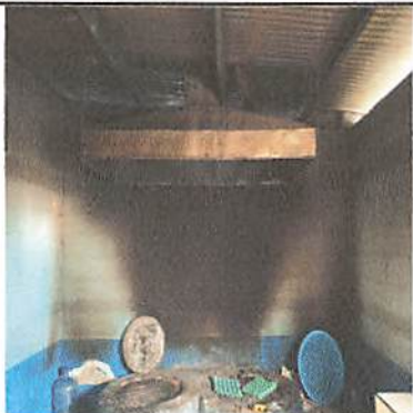
Foto 1: Mantenimiento a estufa rural.
