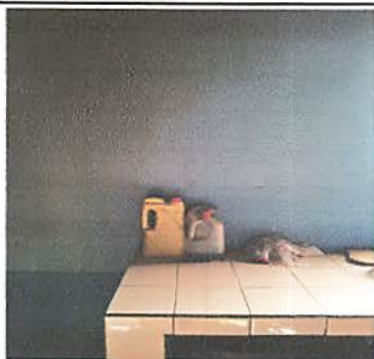
Foto 5: Reparación de azulejos en muebles de cocina.
