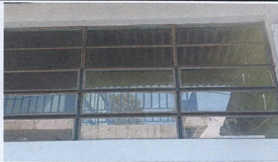
Foto 7: Modificación de ventana de cocina para mejorar la ventilación en la misma.
