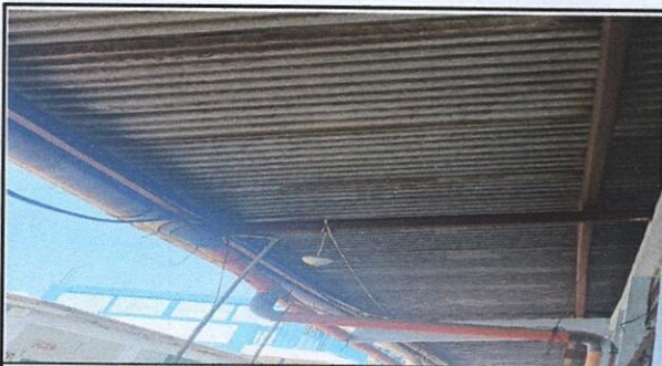
Foto 5: Las costaneras y láminas de tres salones de clases se encuentran oxidadas al igual que los soportes de las mismas.
