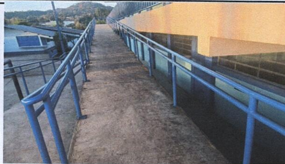
Foto 1: Modificación de relas para rampa, actualmente representan un peligro para los estudiantes.
