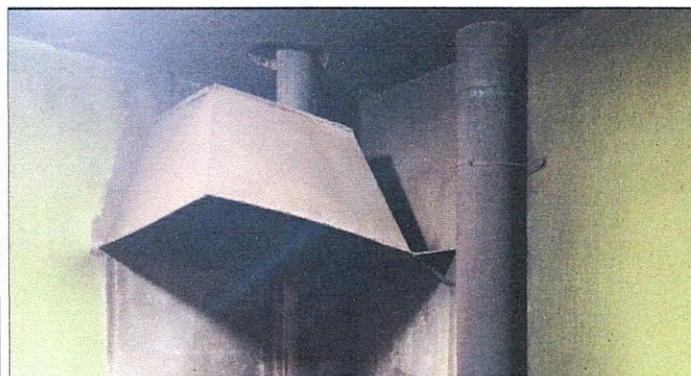
Foto 3: Cambio de campana y corrección de chimeneas
