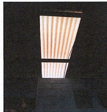
Foto 2: Sustitución de lámina, por lámina troquelada aluzinc.
