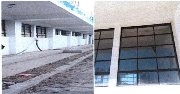
Foto 2: Mantenimiento de balcones
