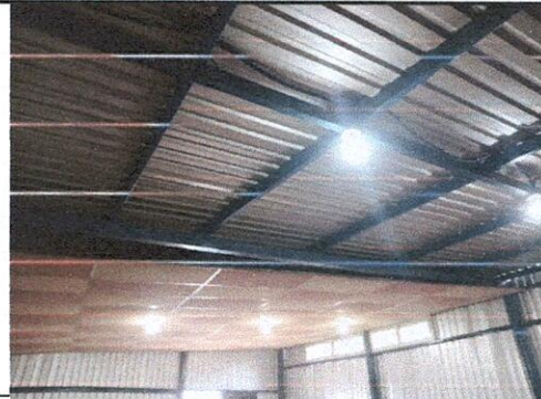
Foto 2: Complemento de cielo falso.
