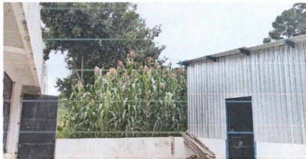
Foto 3: Ampliación de pared de lámina de Aluzinc
