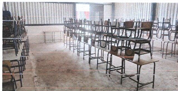
Foto 6: Colocación de piso cerámico
