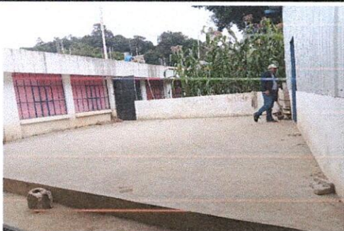
Foto1: Ampliación de techado
