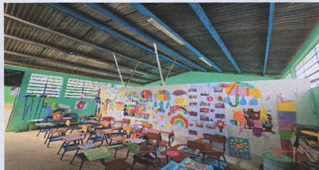
Foto 2: Interior de salón 2 para remozar sistema eléctrico, piso y cielo falso.
