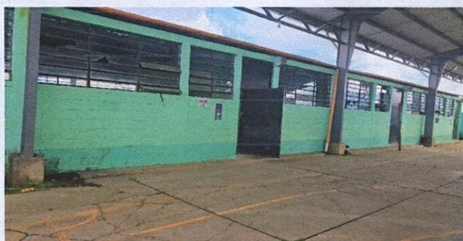
Foto 3: Fachada de los salones a remozar.
