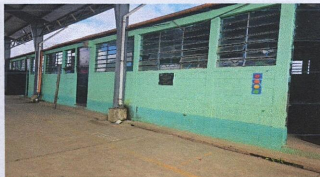
Foto 4: Fachada de los salones a remozar.
