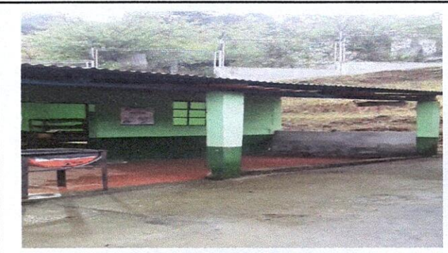
Foto 4: Cambio de estructura y cubierta de láminas
