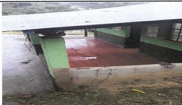
Foto 1: Cambio de Ventanas
