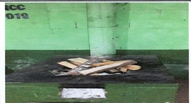
Foto 6: Demoler pollo y construcción nueva
