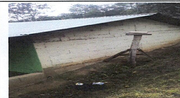
Foto 5: Ampliación de la cocina
