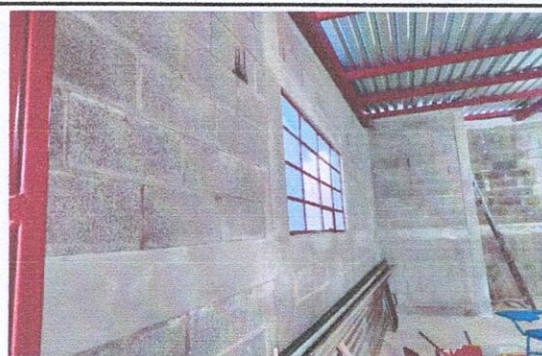
Foto 4: Pintura en muro interior de cocina
