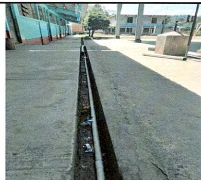
Foto 6: Reparación de red de drenajes y agua potable
