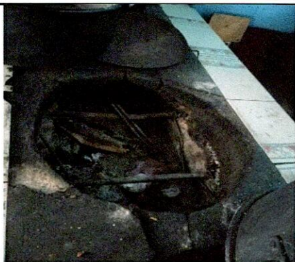
Foto1: Reparación área de cocina
