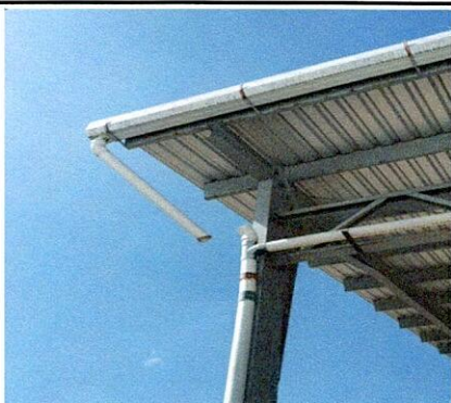
Foto 3: Reparación de canales y bajadas de agua pluvial
