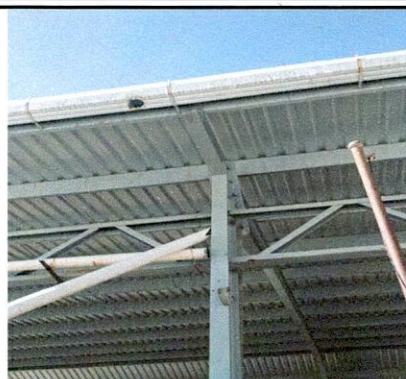
Foto 2: Reparación de canales y bajadas de agua pluvial
