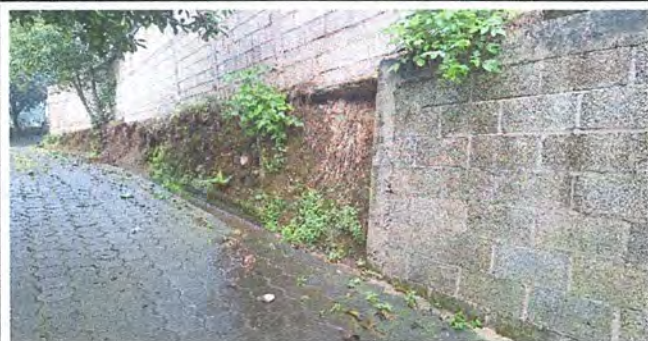
Foto1: Ampliación de pared de muro perimetral
