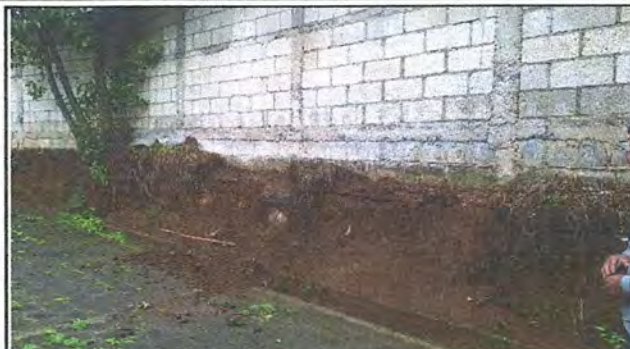
Foto 2: Ampliación de pared de 30 metros de largo por 2.80 metros de altura
