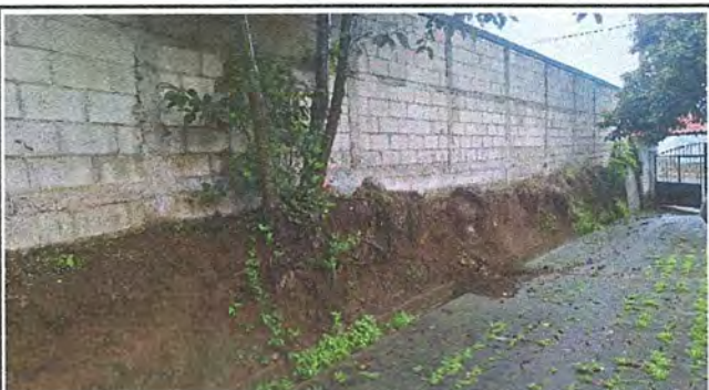
Foto 3: Remozamiento de muro de contención de 30 metros de largo por 1 metro de profundidad.
