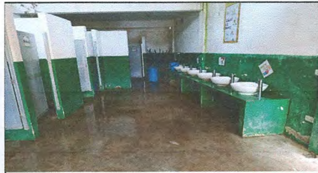
Foto 8: Mantenimiento de pared de Sanitarios
