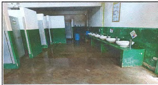
Foto 9: Mantenimiento de piso de lavamanos y sanitarios.
