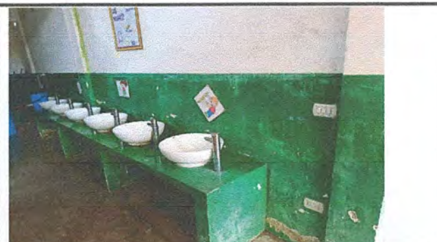
Foto 10: Cambio de piso de sanitarios
