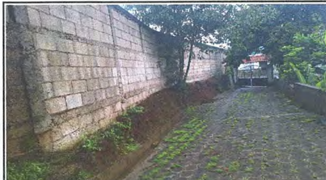
Foto 4: Reforzamiento de muro de contención de 1.80 metros de altura por 1 metro de profundidad de cimiento corrido.
