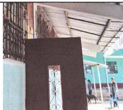
Foto 3: Mantenimiento a estructura de puertas.
