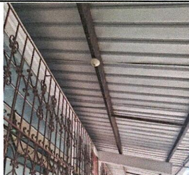
Foto 2: Reparación de sistema eléctrico.
