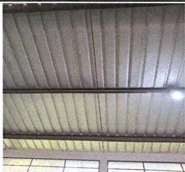
Foto 1: Reparación de cielo falso en 6 aulas, dirección y bodega.
