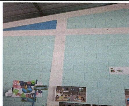
Foto 4: Pintura en 6 aulas dirección y cocina dentro y fuera.
