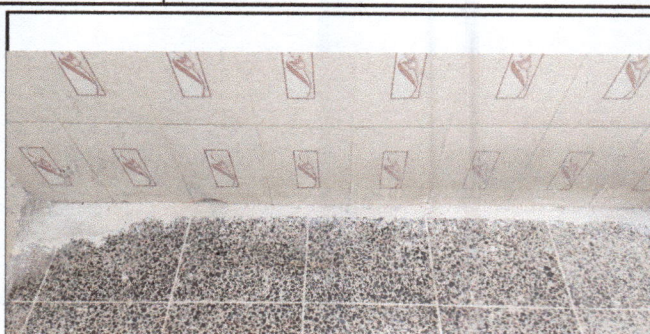
Foto2.1 Sustitución de tubería de línea principal de entrada y salida de agua para cocina y baños de hombre y mujeres en el primer nivel.
