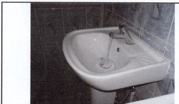
Foto 3. Sustitución de lavamanos actual por lavamanos con pedestales nuevos con grifo de tipo push (ahorradore de agua)
