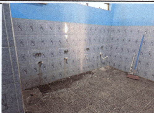
Foto2.1 Sustitución de tubería de línea principal de entrada y salida de agua para cocina y baños de hombre y mujeres en el primer nivel.
