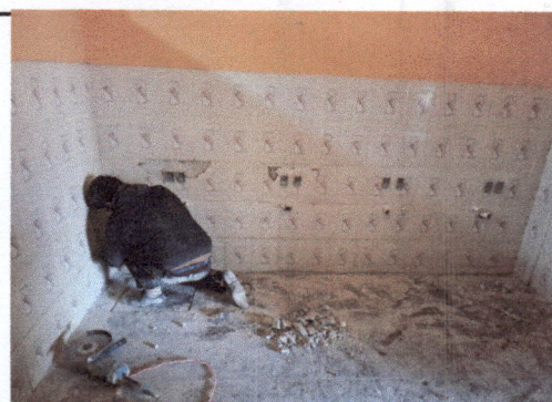
Foto2.3 Sustitución de tubería de línea principal de entrada y salida de agua para cocina y baños de hombre y mujeres en el primer nivel.
