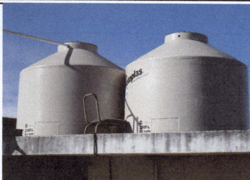
Foto1. Sustitución de dos tinacos de 1200 litros por dos tinacos de 2500 litros de agua marca rotoplast.
