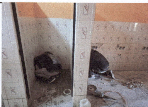
Foto2.2 Sustitución de tubería de línea principal de entrada y salida de agua para cocina y baños de hombre y mujeres en el primer nivel.
