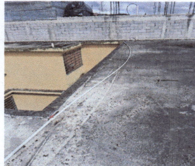
Foto2.1 Sustitución de tubería de línea principal de entrada y salida de agua para cocina y baños de hombre y mujeres en el primer nivel.
