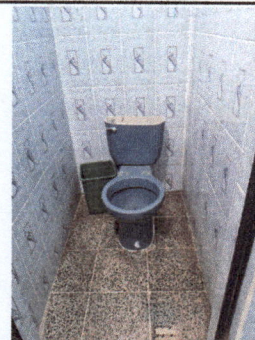
Foto 4: Sustitución de inodoro de palanca por inodoros con sistema de agua tipo push (ahorradores de agua)
