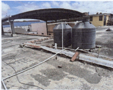
Foto1. Sustitución de dos tinacos de 1200 litros por dos tinacos de 2500 litros de agua marca rotoplast.
