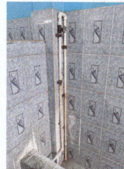
Foto2.3 Sustitución de tubería de línea principal de entrada y salida de agua para cocina y baños de hombre y mujeres en el primer nivel.
