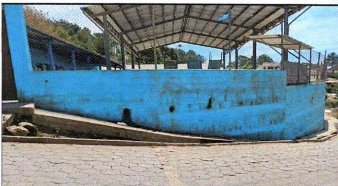
Foto 3: Pintura en muros interior y exterior.
