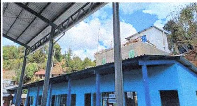
Foto 8: Canales y bajadas de agua pluvial.
