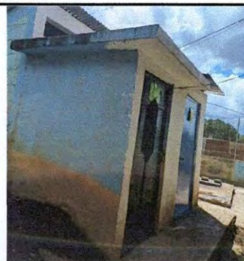
Foto 4: Reparación y mantenimiento de cisternas/depósito de agua.
