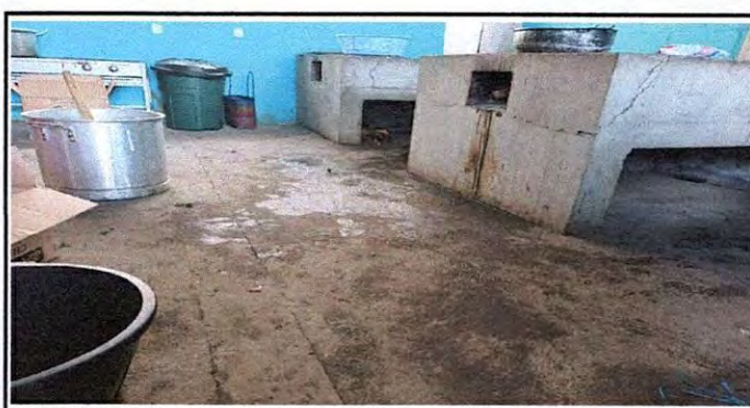
Foto 6: Reparación de cocina
