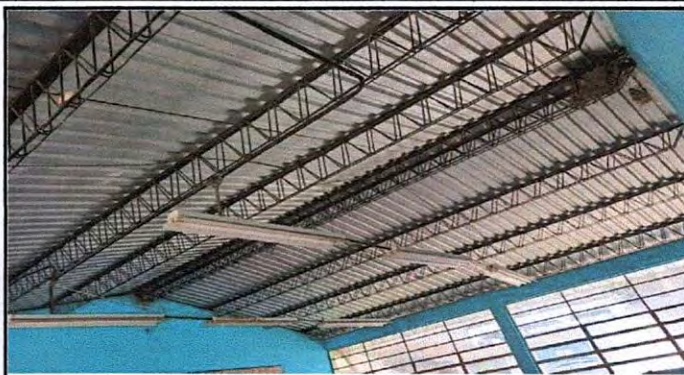
Foto 2: Reparación de sistema eléctrico.
