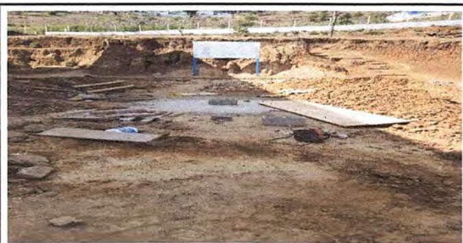
Foto 5: Reparación de patio.
