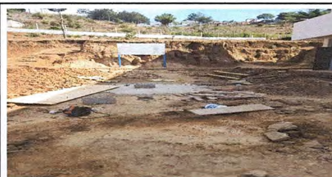
Foto 6: Reparación de patio.
