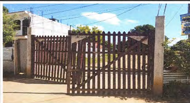
Foto 2: Reparación de portón, entrada principal del establecimiento y elaboración de techo.
