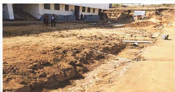
Foto 3: Reparación de cunetas.
