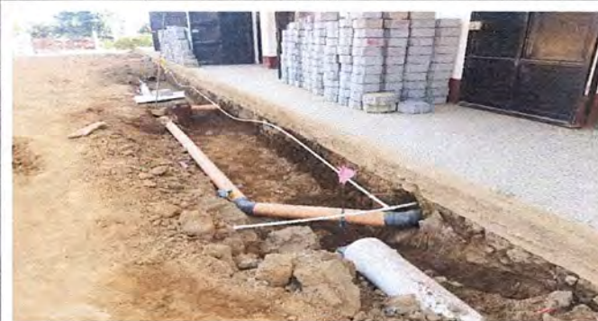
Foto 4: Reparación de cunetas.
