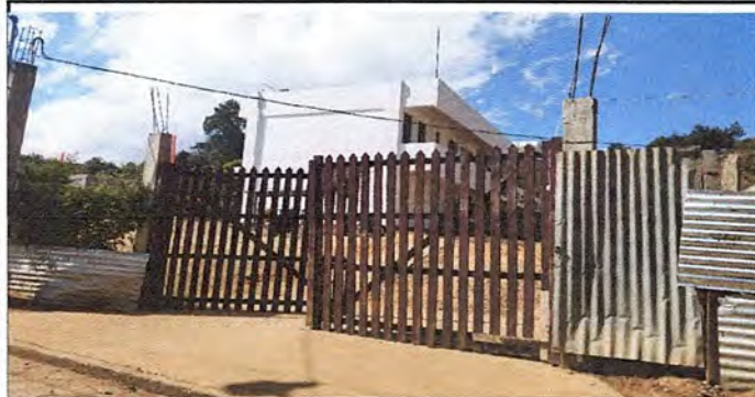
Foto 1: Reparación de portón, entrada principal del establecimiento y elaboración de techo.
