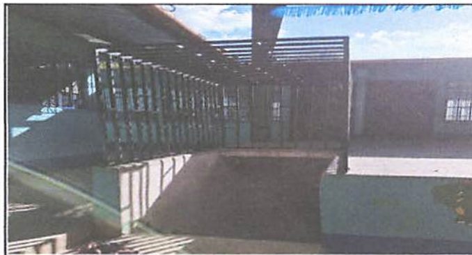
Foto 2. Colocación de baranda para la protección de estudiantes.
