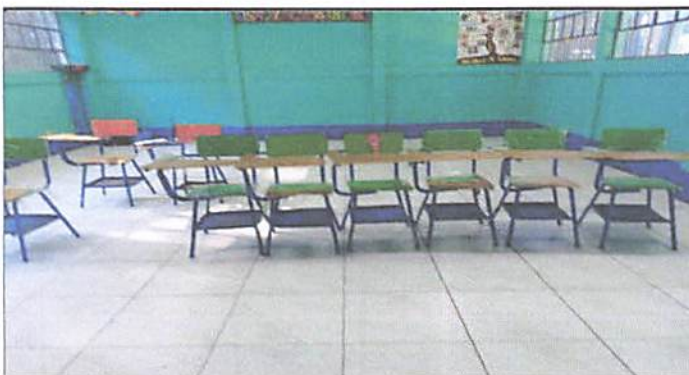
Foto 1.3 Colocación de piso cerámico antideslizante en cinco aulas.
