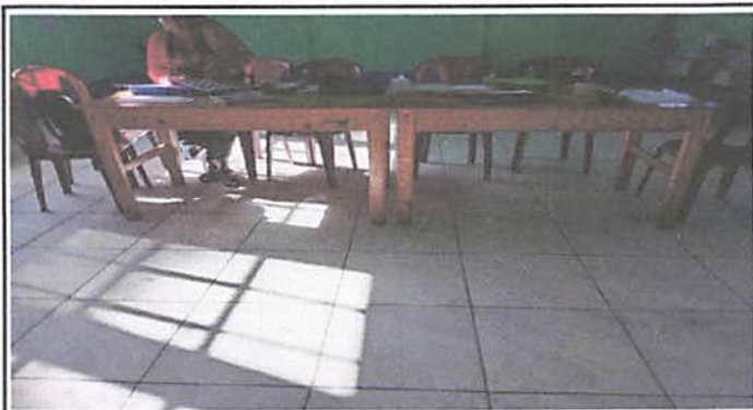
Foto 1.1 Sustitución de piso de torta de concreto por piso cerámico antideslizante en cinco aulas.
