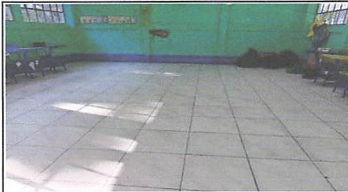
Foto 1.2 Colocación de piso cerámico antideslizante en cinco aulas.
