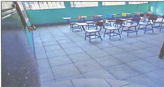
Foto 1.5 Colocación de piso cerámico antideslizante en cinco aulas.
