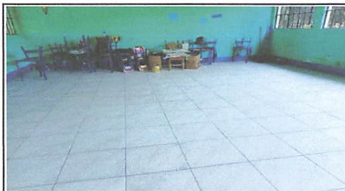
Foto 1.4 Colocación de piso cerámico antideslizante en cinco aulas.
