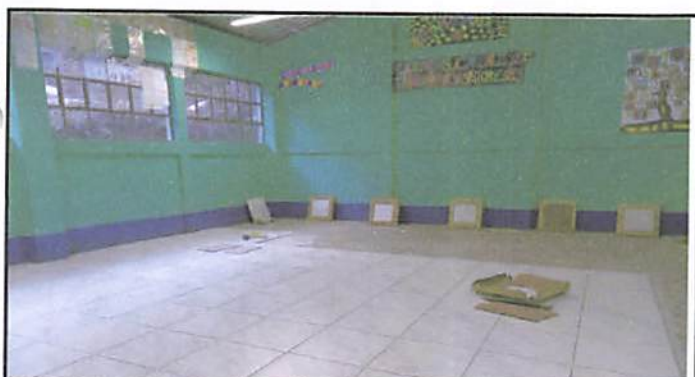
Foto1.3 Sustitución de piso de torta de concreto por piso cerámico antideslizante en cinco aulas.
