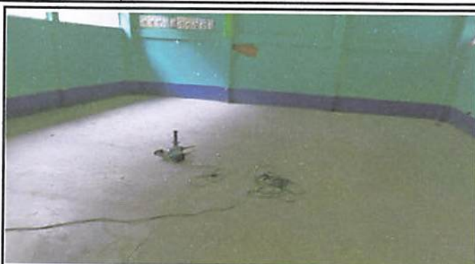
Foto1.2 Sustitución de piso de torta de concreto por piso cerámico antideslizante en cinco aulas.
