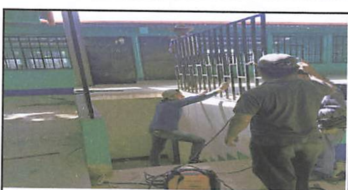
Foto 2: Fabricación de baranda de protección.
