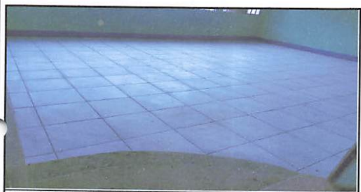
Foto1.5 Sustitución de piso de torta de concreto por piso cerámico antideslizante en cinco aulas.
