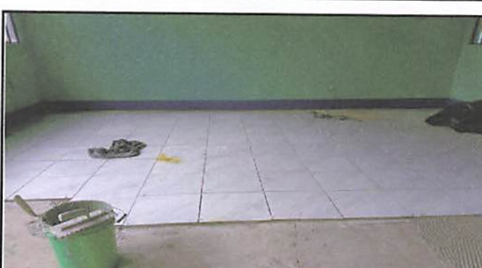
Foto1.4 Sustitución de piso de torta de concreto por piso cerámico antideslizante en cinco aulas.
