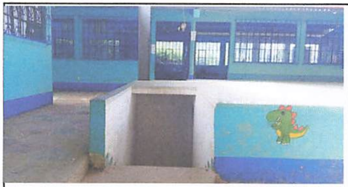
Foto 6: Fabricación de baranda de protección.
