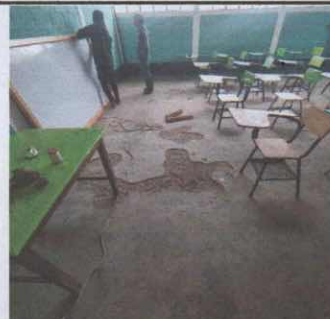
Foto 6: Sustitución de losa por piso cerámico en tres salones de clase.
