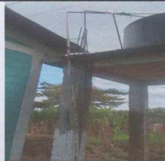
Foto 4: Sustitución de depósito, tubería y accesorios, desde el tinaco hasta los sanitarios.
