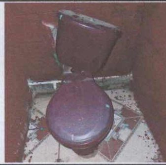
Foto 2: Sustitución de inodoros en los sanitarios de mujeres y sanitarios de hombres.
