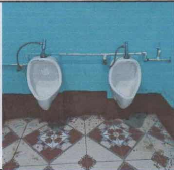
Foto 1: Sustitución de mingitorios en los sanitarios de varones.
