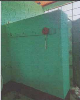
Foto 3: Colocación de azulejos en paredes de sanitarios.
