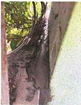
Foto 9: IMPERMEABILIZACIÓN DE PARED DE COCINA.
