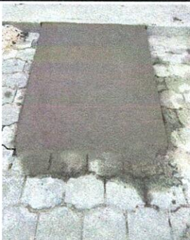
Foto 11: RAMPA DE PATIO.
