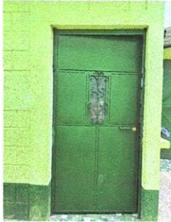
Foto 7: REPARACIÓN DE PUERTA DE COCINA.
