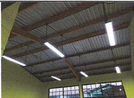
Foto1: SUSTITUCIÓN DE ENERGÍA ELÉCTRICA, SALÓN 1
