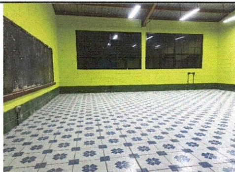
Foto 3: CAMBIO DE PISO DE CEMENTO PULIDO POR PISO ANTIDESLIZANTE. SALÓN 1.
