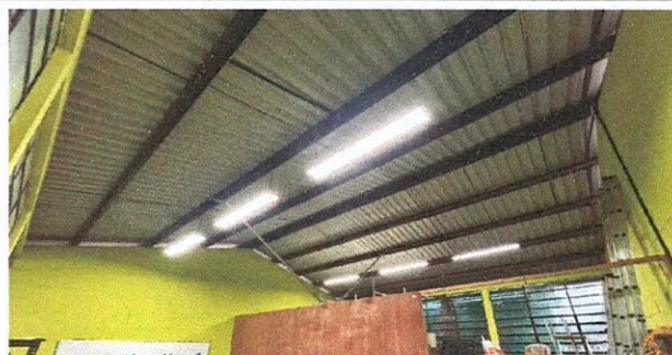
Foto 2: SUSTITUCIÓN DE ENERGÍA ELÉCTRICA, SALÓN 2.
