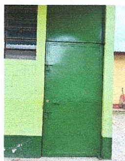
Foto 6: REPARACIÓN DE PUERTA. SALÓN.2
