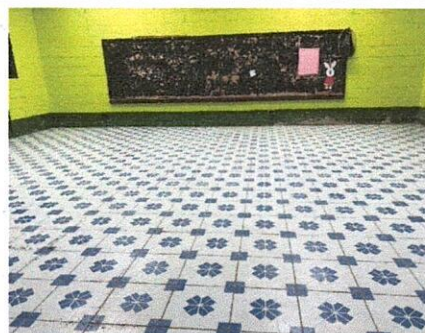
Foto 4: CAMBIO DE PISO DE CEMENTO PULIDO POR PISO ANTIDESLIZANTE. SALÓN 2.
