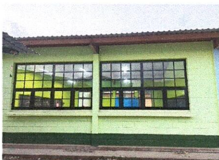
Foto 5: CAMBIO DE VENTANAS. SALÓN 1.
