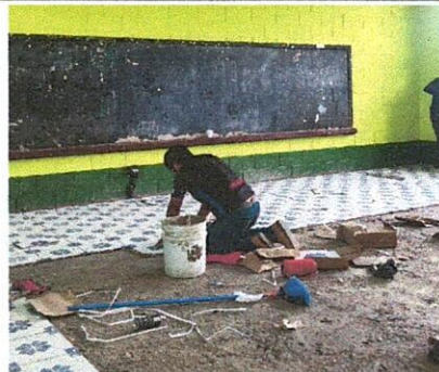
Foto 4: CAMBIO DE PISO DE CEMENTO PULIDO POR PISO ANTIDESLIZANTE. SALÓN 2.
