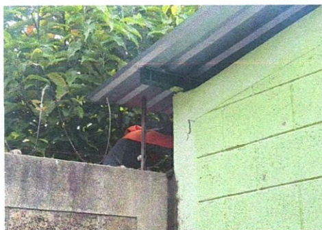
Foto 9: IMPERMEABILIZACIÓN DE PARED DE COCINA.
