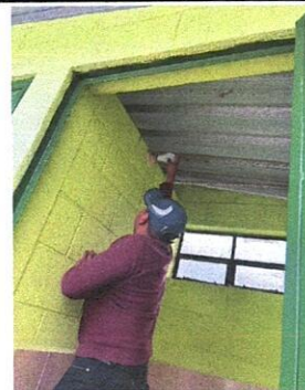
Foto 8: INSTALACIÓN DE ENERGÍA ELÉCTRICA EN SANITARIOS.
