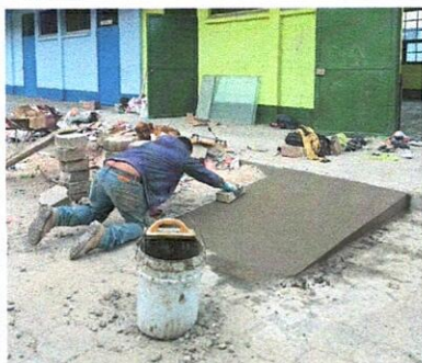
Foto 11: RAMPA DE PATIO.
