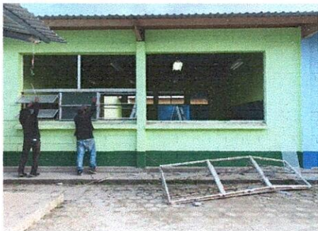
Foto 5: CAMBIO DE VENTANAS. SALÓN 1.
