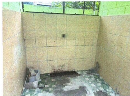
Foto 10: MANTENIMIENTO DE ÁREA DE PILA
