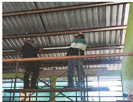
Foto 2: SUSTITUCIÓN DE ENERGÍA ELÉCTRICA, SALÓN 2.
