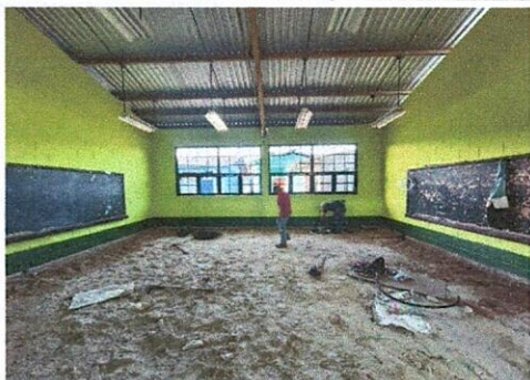
Foto 3: CAMBIO DE PISO DE CEMENTO PULIDO POR PISO ANTIDESLIZANTE. SALÓN 1.
