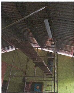
Foto1: SUSTITUCIÓN DE ENERGÍA ELÉCTRICA, SALÓN 1
