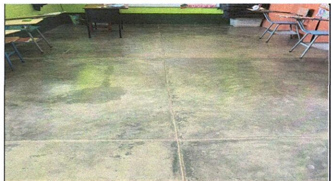
Foto 4: CAMBIO DE PISO DE CEMENTO PULIDO POR PISO ANTIDESLIZANTE. SALÓN 2.
