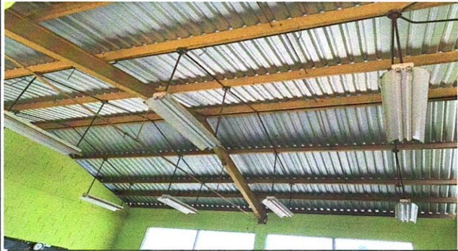
Foto1: SUSTITUCIÓN DE ENERGÍA ELÉCTRICA, SALÓN 1
