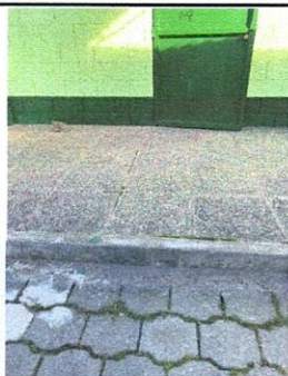
Foto 11: RAMPA DE PATIO.
