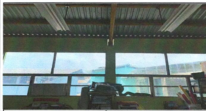
Foto 5: CAMBIO DE VENTANAS. SALÓN 1.
