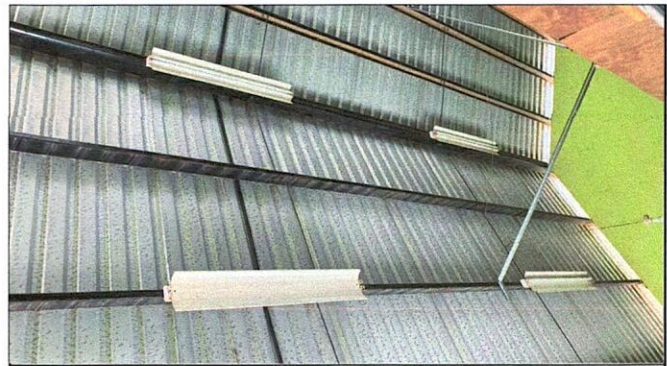
Foto 2: SUSTITUCIÓN DE ENERGÍA ELÉCTRICA, SALÓN 2.
