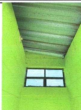
Foto 8: INSTALACIÓN DE ENERGÍA ELÉCTRICA EN SANITARIOS.
