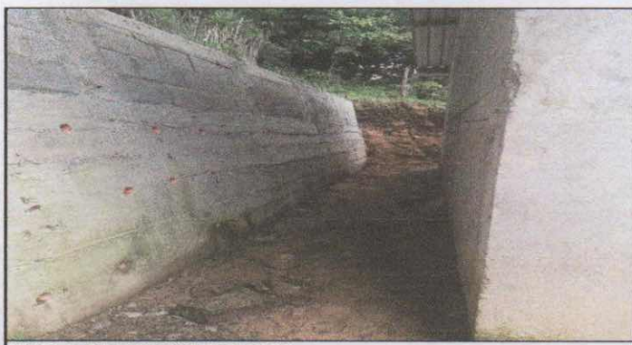
FOTO 4: REPARACION DE PARED
