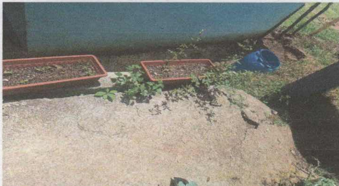
FOTO 2: LOSA DE PATIO
