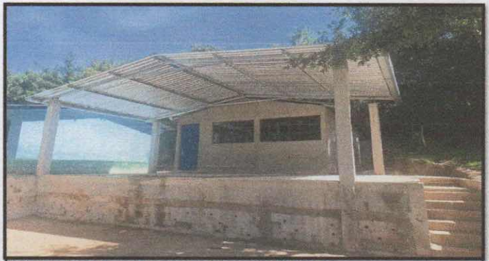
FOTO 5: CANALES Y BAJADAS DE AGUA PLUVIAL
