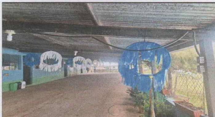
FOTO 6: REPARACION SISTEMA ELECTRICO
