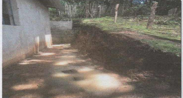
FOTO 2: LOSA DE PATIO
