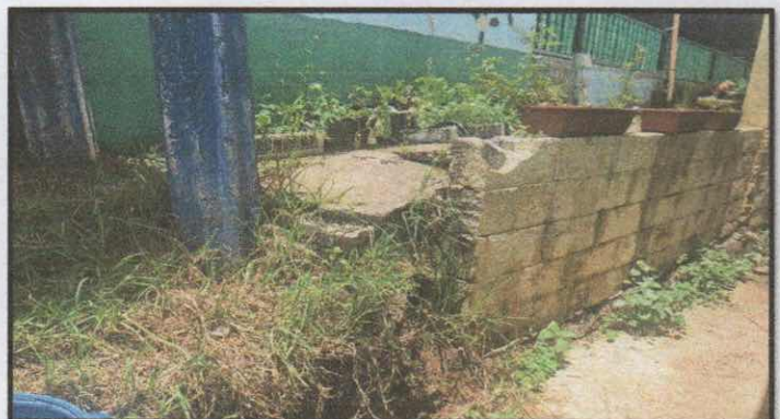
FOTO 3: REPARACION DE PARED
