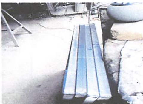
Foto 3: Realizacion de cambio de porton.
