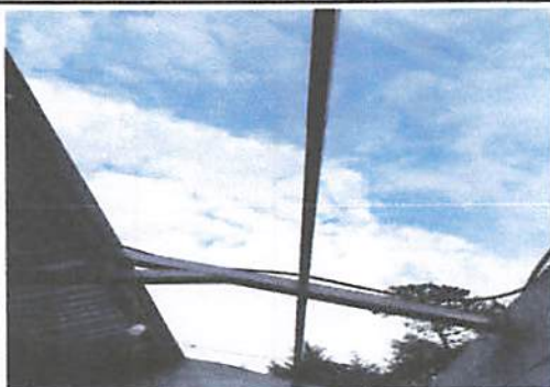
Foto1: Trabajando la remodelacion del techo de nuestra cocina.
