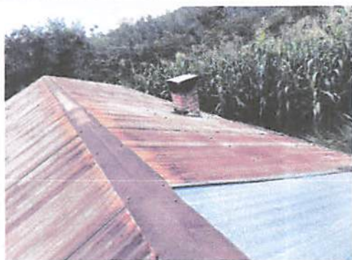
Foto 1: Reparación y cambio de techado de cocina por filtración de agua y deterioro total de la misma.
