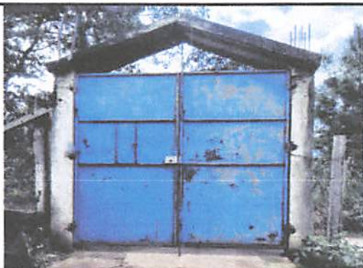
Foto 3: Reparación y sustitución de porton por deterioro.
