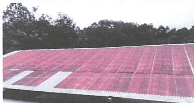
Foto 2: Reparación y cambio de techado de cancha por filtración de agua y deterioro total de la misma.
