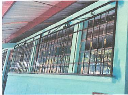
Foto 2: Remodelacion de valcones en un 100%
