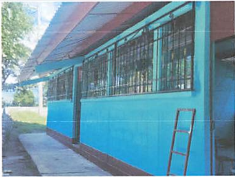
Foto1: Remodelación de techo ya en un 100%
