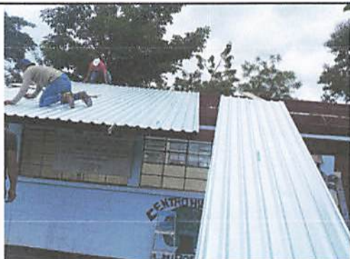
Foto 5: Colocación de lamina
