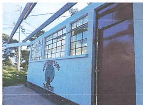
Foto 4: Remodelación de Techo de salones
