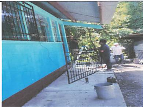
Foto 1: Remodelación de balcones
