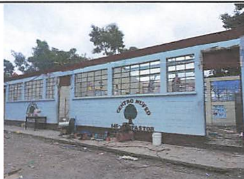
Foto 2: Remodelación de Techo de salones
