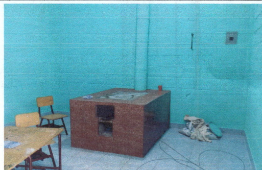
Foto 4: Remodelacion colocacion de azulejo al pollo de la cocina finalizado
