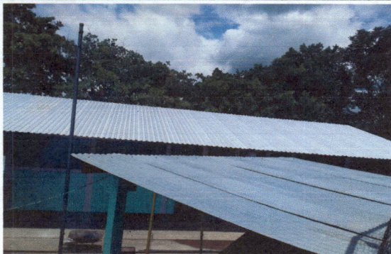
Foto 1: Remodelacion de techado de 3 aulas estructura y laminado
