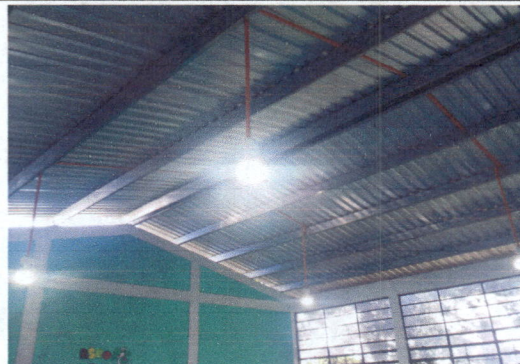
Foto 2: Reparacion del sistema electrico
