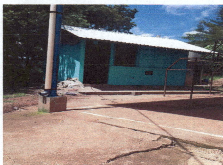
Foto 3: Remodelacion de techado de cocina estructura y laminado, reparacion del sistema electrico finalizado
