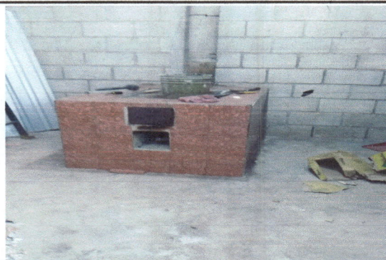
Foto 4: Remodelacion colocacion de azulejo al pollo de la cocina
