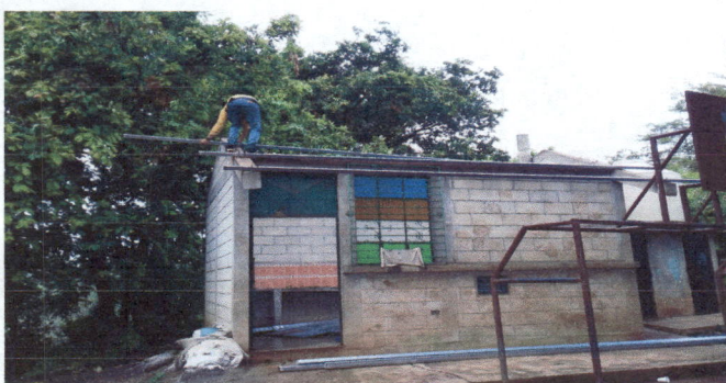
Foto 3: Remodelacion de techado de cocina estructura y laminado, reparacion del sistema electrico
