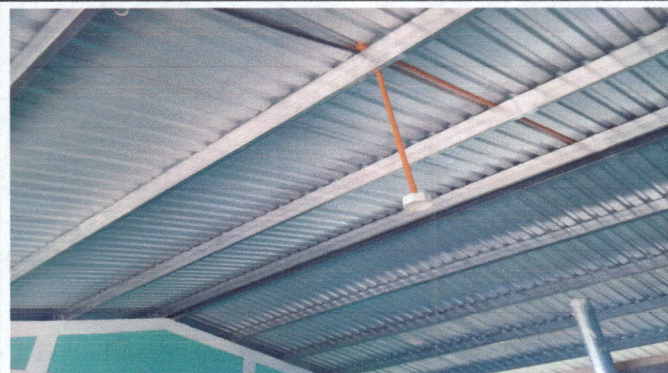
Foto 2: Reparacion del sistema electrico
