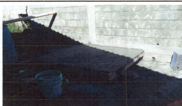
Foto 6: Reparacion captacion de agua de sisterna colocacion de tinaco
