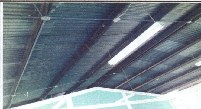
Foto 2: Reparacion del sistema electrico
