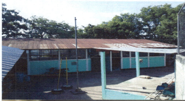
Foto 1: Remodelacion de techado de 3 aulas estructura y laminado
