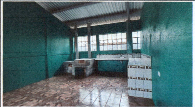
Foto 2: Culminación de colocación de piso en la cocina.
