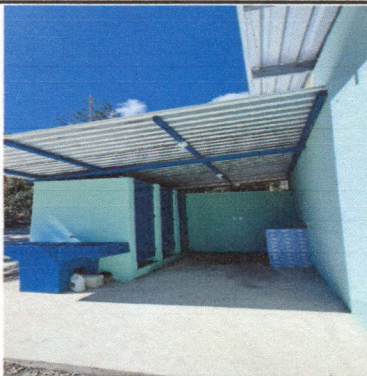
Foto 3: Finalización de muro tabique y techo en sanitarios
