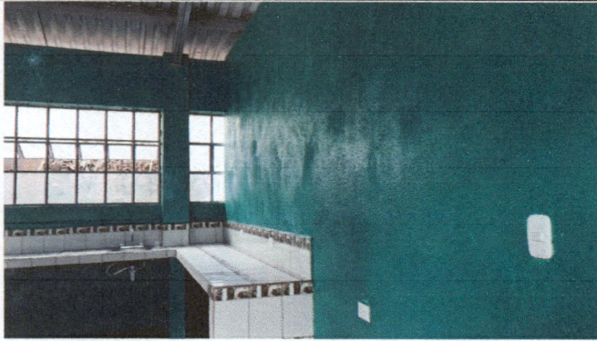
Foto1: finalización de muro tabique y pollos con chimenea para cocina.
