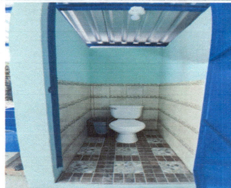
Foto 4: Culminación de piso cerámico y sanitarios.
