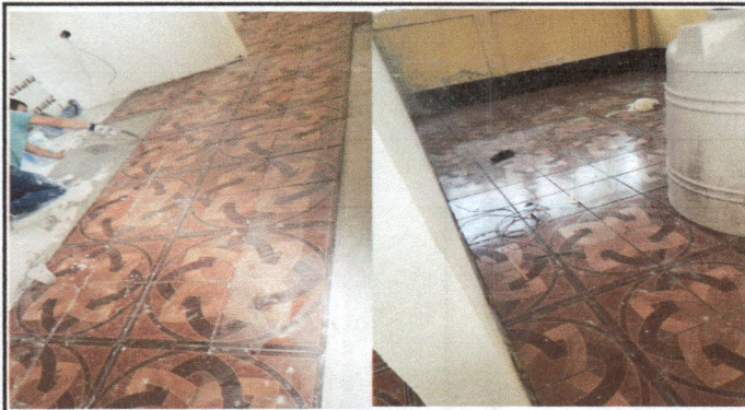
Foto 2: Colocación de piso en la cocina.
