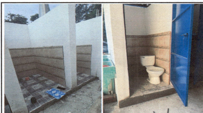
Foto 4: Instalación de piso cerámico y sanitarios.
