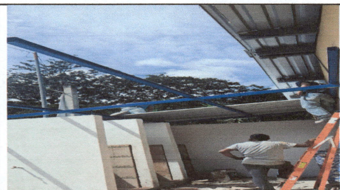
Foto 3: Colocación de muro tabique y techo en sanitarios
