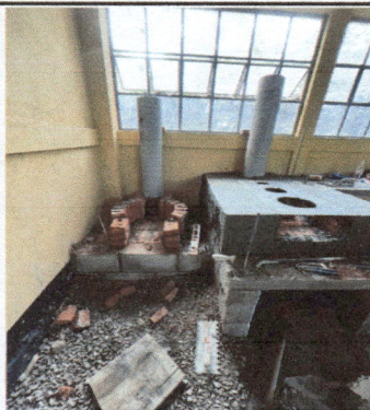
Foto1: Colocación de muro tabique y pollos con chimenea para cocina.
