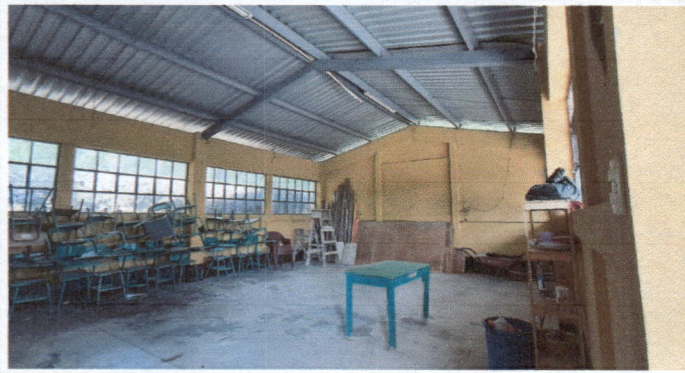
Foto1: Salón grande donde se colocará un muro tabique y realizará gabinete y pollo con chimenea para cocina.
