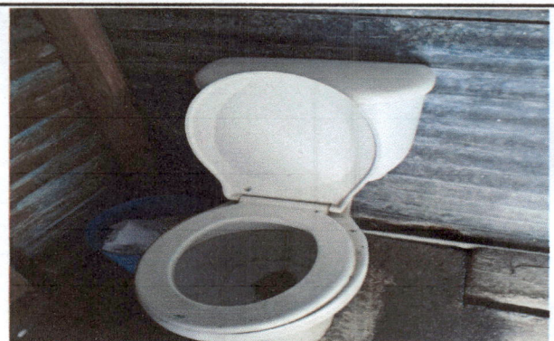
Foto 4: Cambio de sanitario
