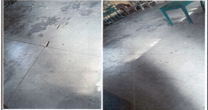
Foto 2: Cambio de piso en Cocina
