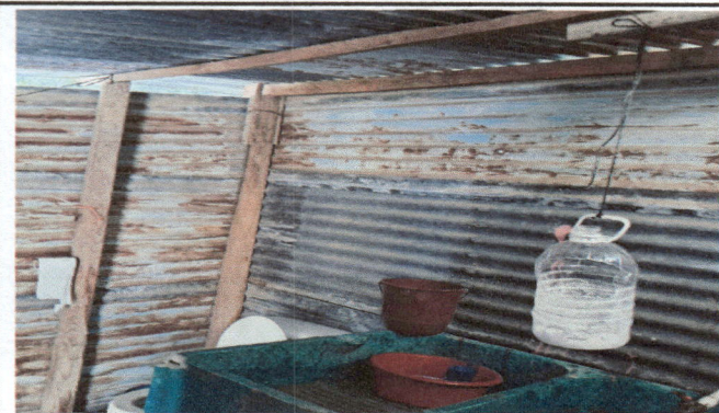
Foto 3: Cambio de techo en sanitarios
