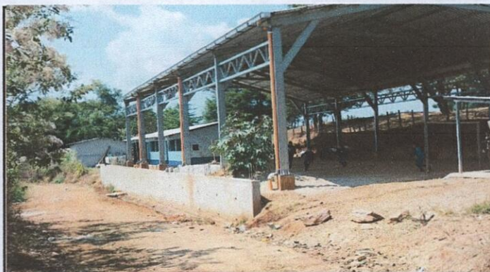
Foto 4: Instalación de malla sobre muro de contención.
