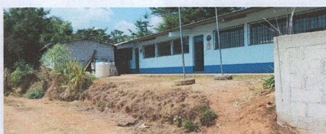
Foto 2: Protección de talud a través del muro de contención.
