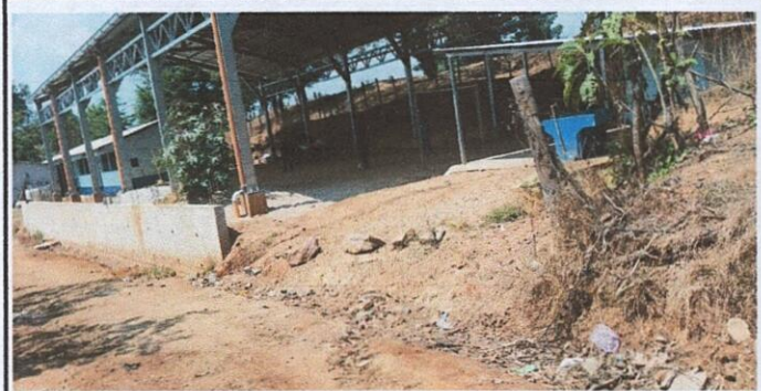
Foto 5: Instalación de portón, acceso principal.
