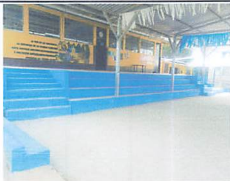
Foto 1: Construcción de graderío que sustituyó muro de contención.
