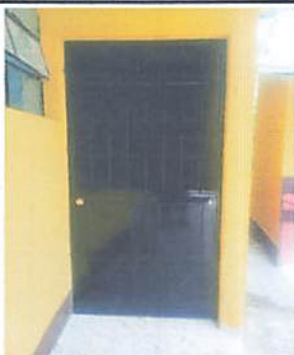
Foto 5: Reparación y remodelación de bodega.
