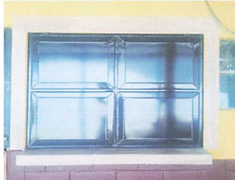
Foto 4: Ampliación de ventana en cocina.
