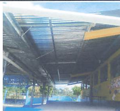
Foto 2: Colocación de cubierta y estructura de techado 1 y 2.
