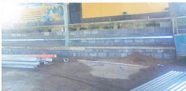
Foto 1: Construcción de graderío que sustituyó muro de contención.
