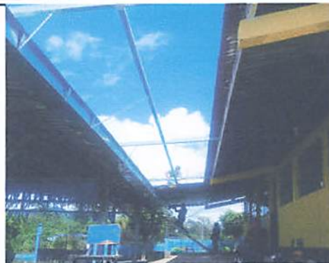
Foto 2: Colocación de cubierta y estructura de techado 1 y 2.
