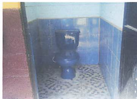
Foto 6: Sustitución de sanitarios.
