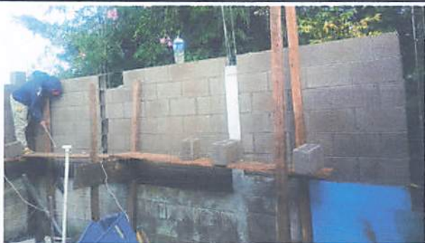
Foto 5: Reparación y remodelación de bodega.
