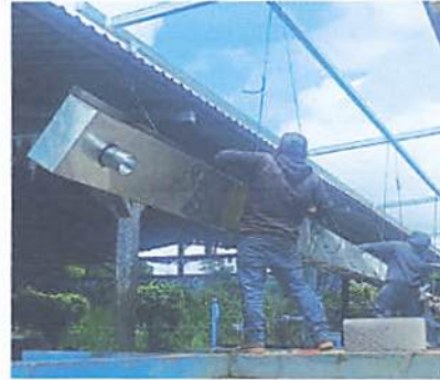
Foto 8: Colocación de canales y bajadas.
