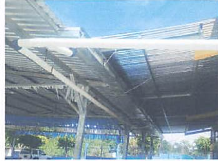
Foto 8: Colocación de canales y bajadas.
