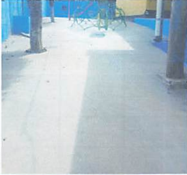
Foto 7: Sustrucción de patio de tierra por torta de cemento
