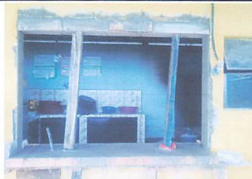
Foto 4: Ampliación de ventana en cocina.
