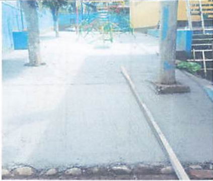
Foto 7: Sustitución de patio de tierra por torta de cemento
