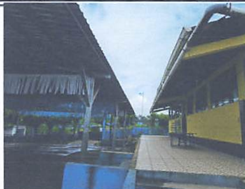
Foto 2: Cubierta y estructura de techado 1 y 2
