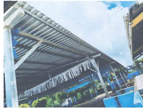
Foto 8: Colocación de canales y bajadas
