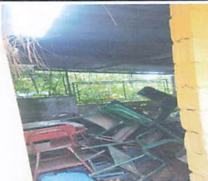
Foto 5: reparación y remodelación de bodega
