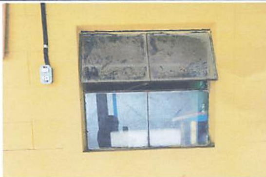
Foto 4: Ampliación de ventana
