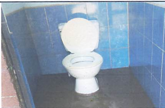
Foto 6: sustitución de sanitarios
