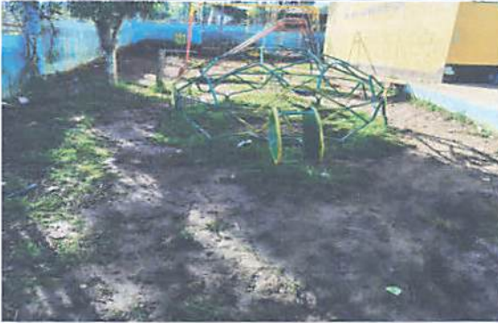
Foto 7: Sustitución de patio de tierra por torta de cemento
