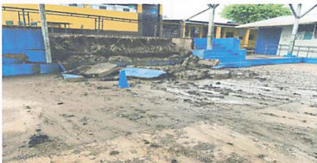
Foto 1: reparación de muro de contención por medio de sustitución por graderío.
