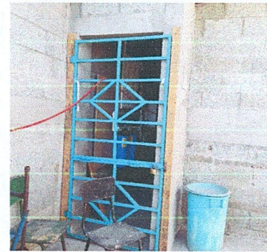
Foto 2: Instalación de puerta y cambio de chapa
