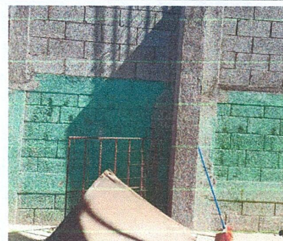
Foto 4: Repello de paredes
