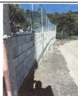
Foto 4: Finalización de Muro perimetral
