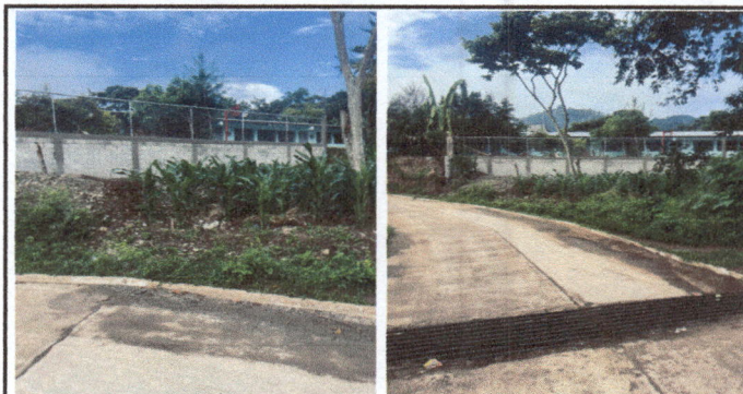
Foto 6: Finalización de Muro perimetral
