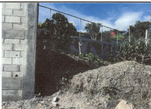
Foto 3: Finalización de Muro perimetral
