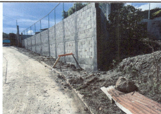
Foto 2: Finalización de Muro perimetral
