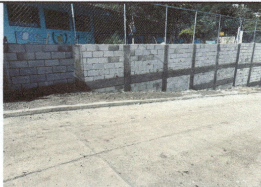
Foto 1: Finalización de Muro perimetral
