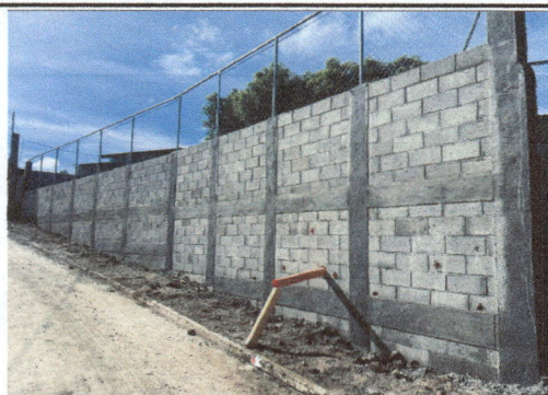
Foto 5: Finalización de Muro perimetral
