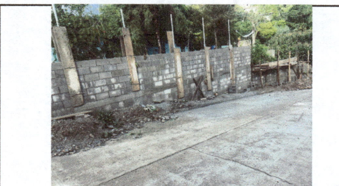
Foto 6: fundición de columnas de Muro perimetral
