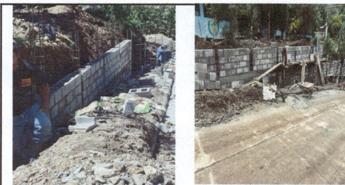
Foto 5: Seguimiento de Muro perimetral
