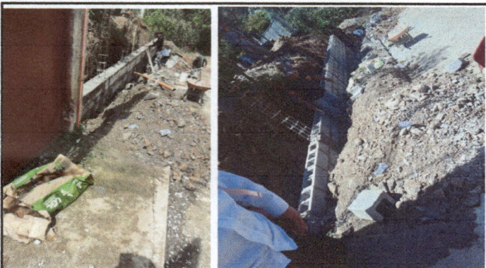
Foto 3: Seguimiento de Muro perimetral
