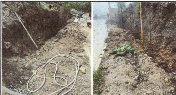
Foto1: Sanjeo para muro perimetral
