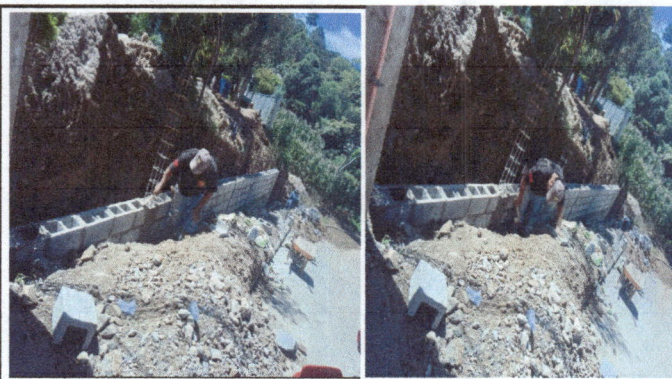
Foto 4: Seguimiento de Muro perimetral
