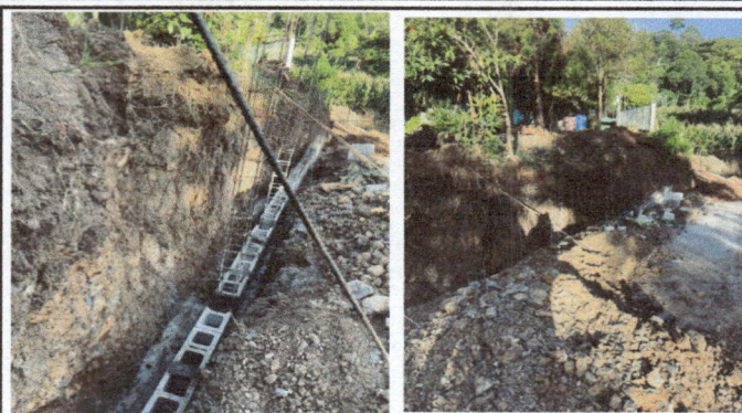
Foto 2: Primer hilado de block para el Muro perimetral
