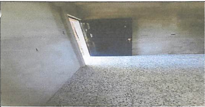
Foto 5: Colocación de piso de granito
