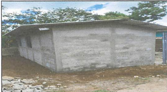
Foto 2: Cambio de techo.
