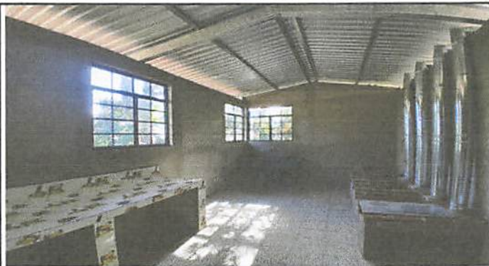
Foto 1: Remozamiento de cocina. Colocación de ventanas
