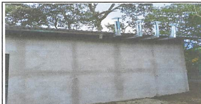
Foto 6: Repello de paredes
