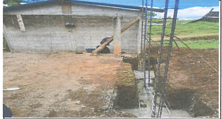
Foto 2: Cambio de techo. Colocación de Columnas.
