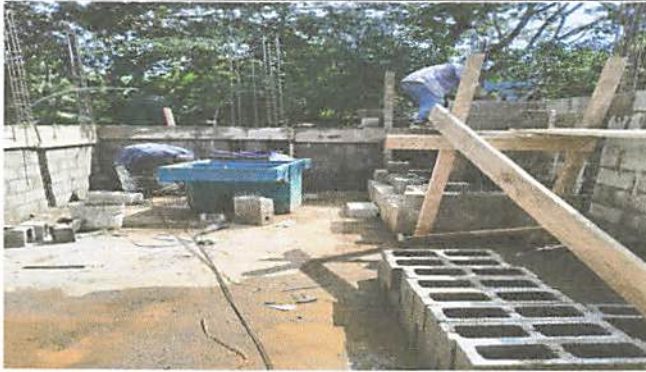
Foto 1: Preparación para colocación de ventanas.
