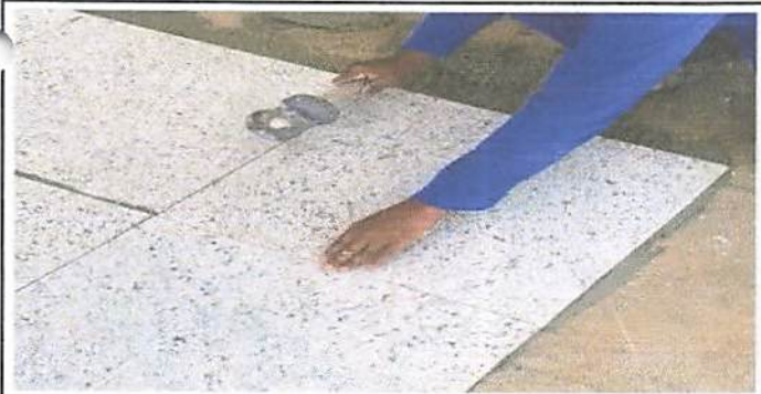
Foto 5: Colocación de piso de granito.
