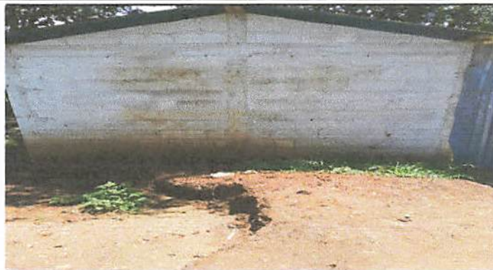
Foto 2: Cambio de techo.
