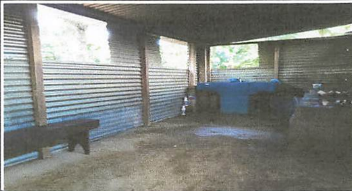
Foto 1: Remozamiento de cocina. Colocacion de ventanas
