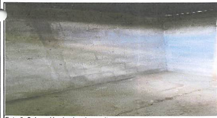
Foto 5: Colocación de piso de granito
