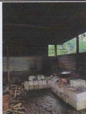
Foto 4: TORTA DE CONCRETO DE COCINA, POLLOS DE TIPO CHURRASQUERA Y CAMBIO DE LAMINAS DE TECHO.
