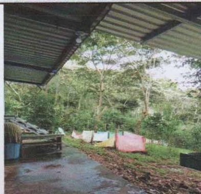
Foto 2: EXTENSIÓN DE TECHADO DE COCINA
