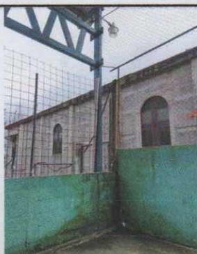
Foto 5: Reparación de tubos de agua de cancha.
