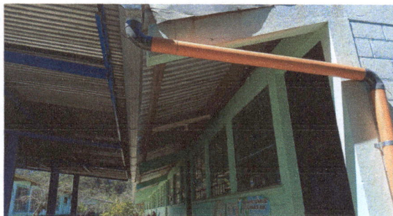
Foto 5: Colocación de 50 metros de canales.
