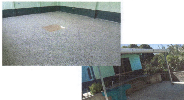
Foto 6: Colocación de pila en introducción del agua potable, y 150 metros de piso.
