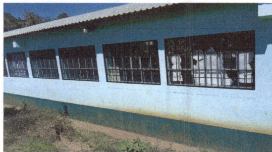
Foto 4: Colocación de 14 balcones.
