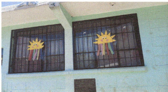
Foto 3: Colocación de 2 balcones.
