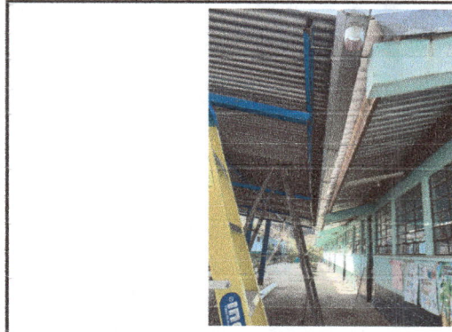
Foto 2: Instalación de Canales.
