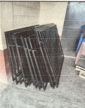
Foto 5: Instalación de Balcones.
