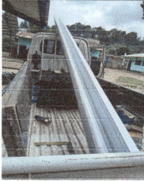
Foto1: Colocación de Canales.
