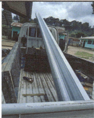
Foto 1: Colocación de Canales.
