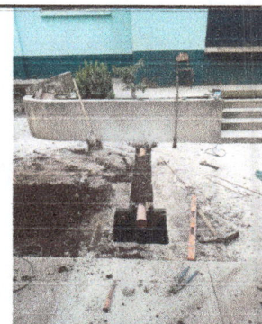
Foto 6: Instalación de drenaje y pila.
