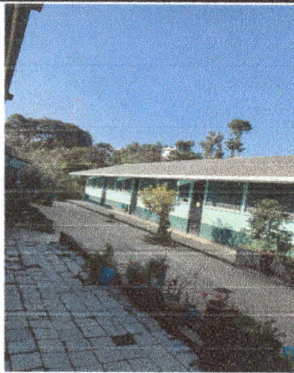
Foto 3: Colocación de Canales
