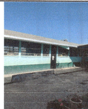
Foto 4: Instalación de balcones.
