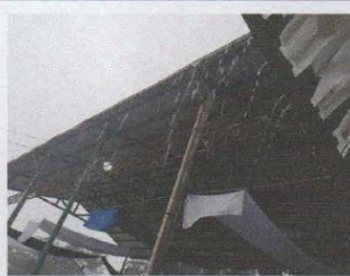
Foto 4: Sustrucción de canales y caídas de agua de la cancha.
