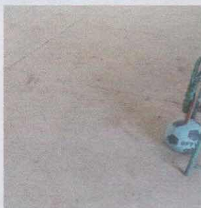
Foto 5: Sustrucción de piso de aula 1.
