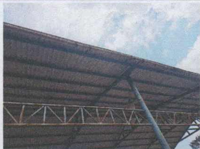
Foto 3: Sustrucción de canales y caídas de agua de la cancha.
