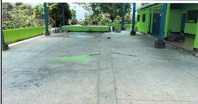
Foto 1: CAMBIO DEL PISO DE LA CANCHA
